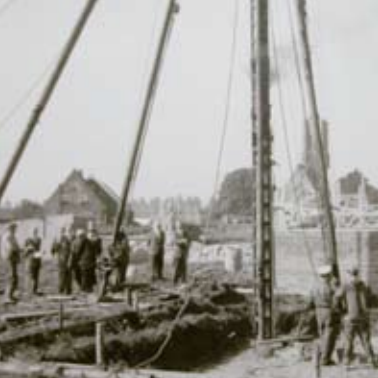
Heipalen worden op het werk gestort.
